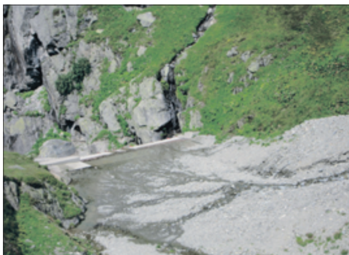
Nutzungsverzicht (4 Massnahmen) Aufgabe der Wasserentnahme bei der Sekundär-Fassung Mattenalp
